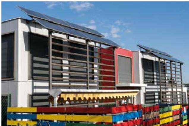
L'installation de Craponne correspond au site le plus productif avec un ratio de 1297 kWh/kWc.
