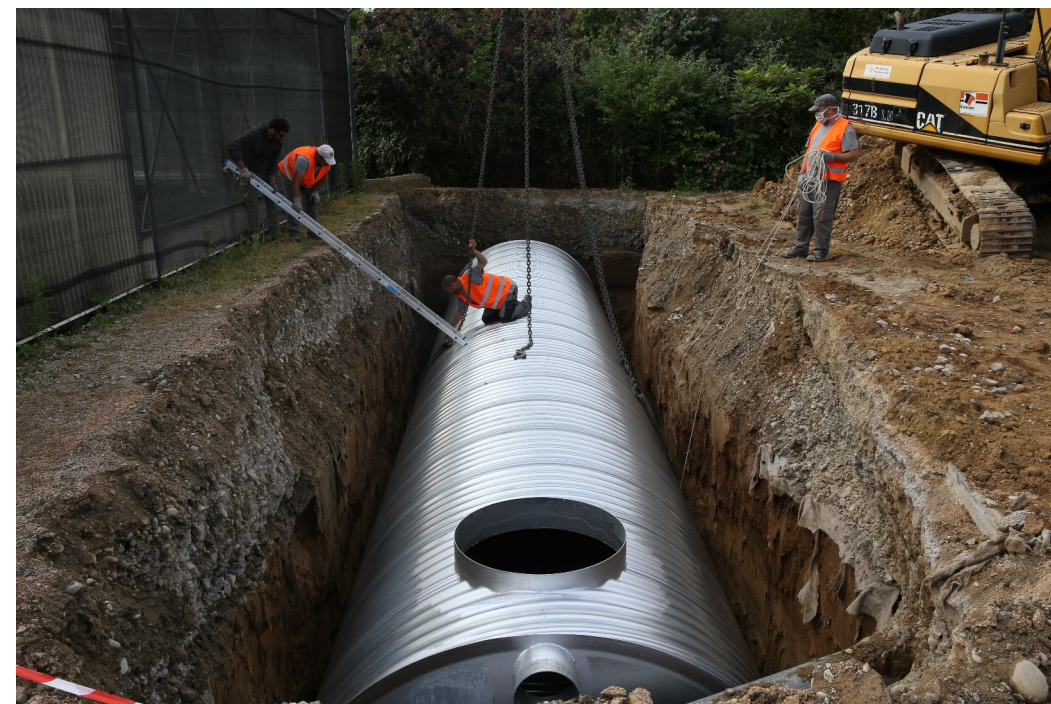
Installation d'une cuve de récupération d'eau de pluie aux serres municipales
