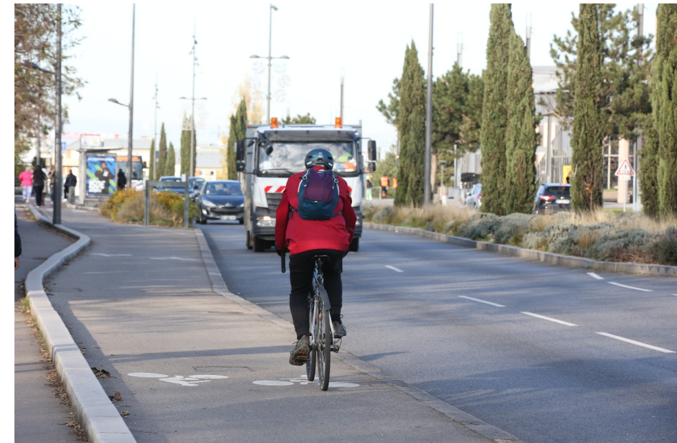
Aménagements de pistes cyclables sur la ville (quartier de la Gare)
