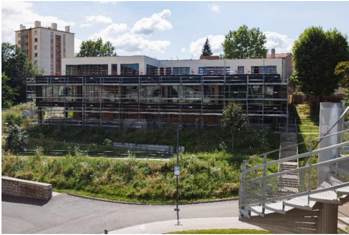
Façade du Bâtiment 59
