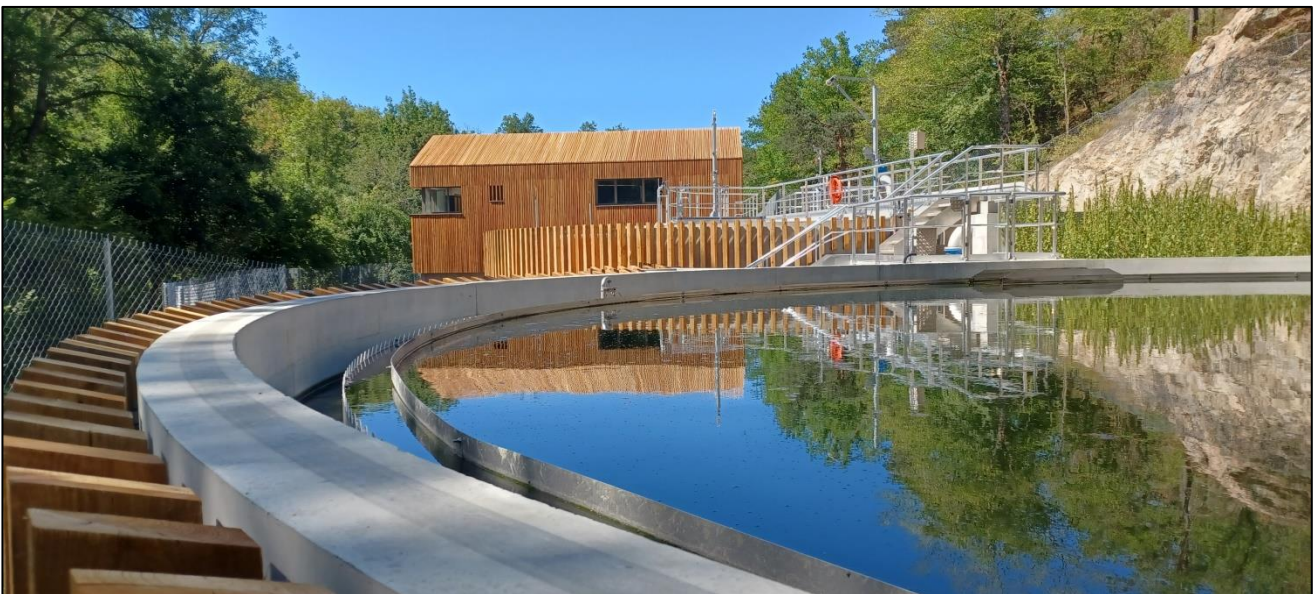
Station d'épuration Saint-Victor-sur-Loire – Les Tourettes
