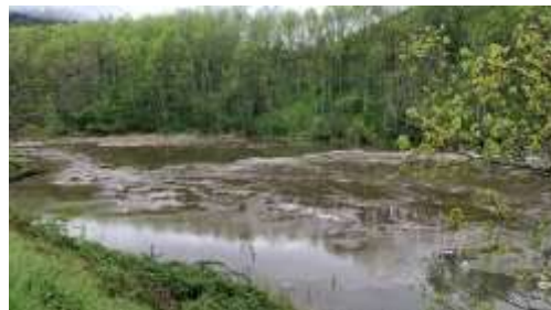
Figure 3 - Entrée du Dorlay (présences de flottants)
