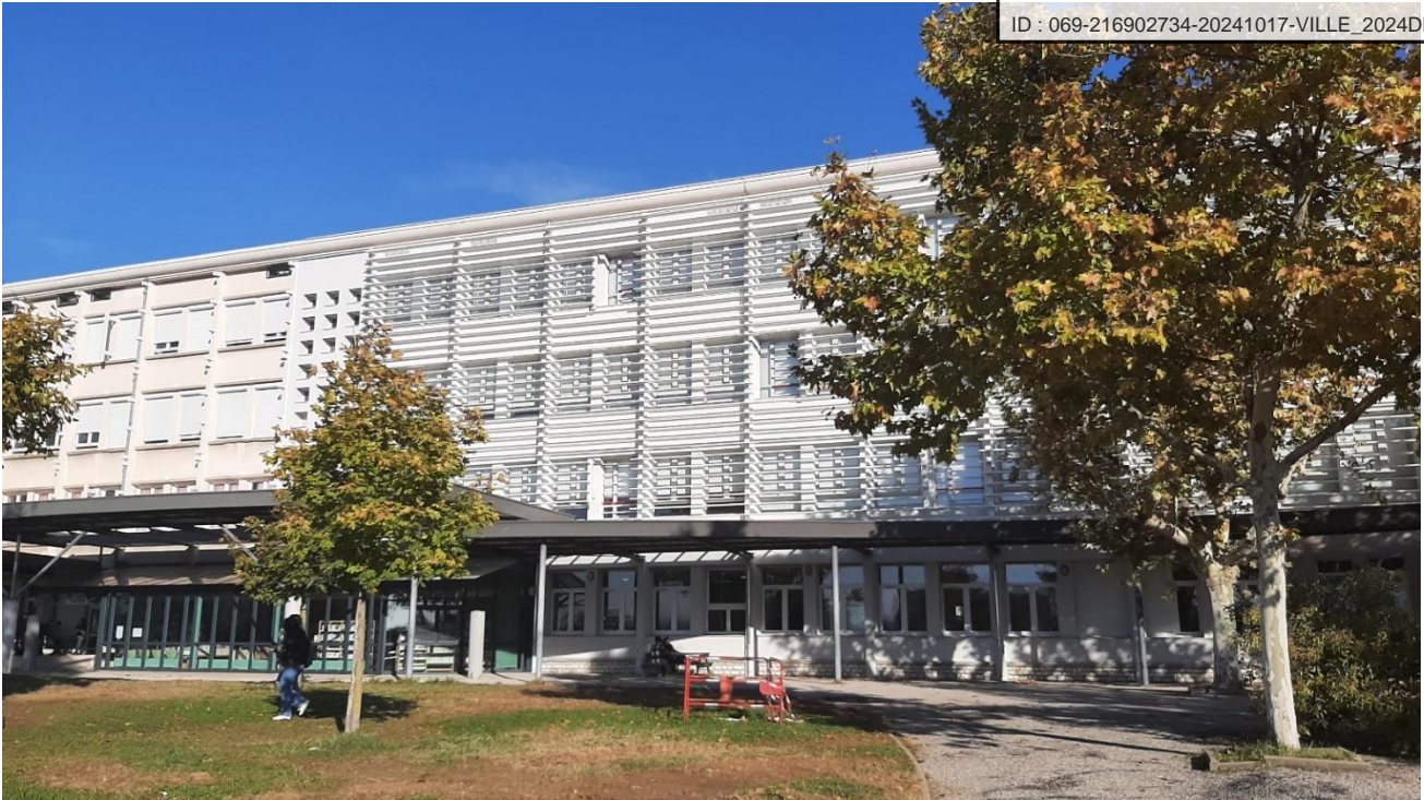
Lycée Albert Triboulet à Romans-sur-Isère pour la Région Auvergne-Rhône-Alpes Objectif de réduction des consommations énergétiques de 41,2 %
