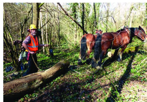
Sur le Merdanson d'Orliénas, les travaux d'entretien de berge ont nécessité l'intervention de chevaux pour évacuer les grumes hors du lit du cours d'eau.
