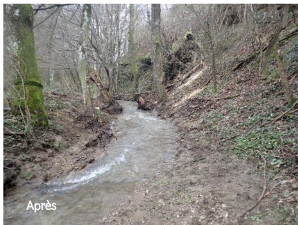
Traitement embâcles sur le Mézerin
