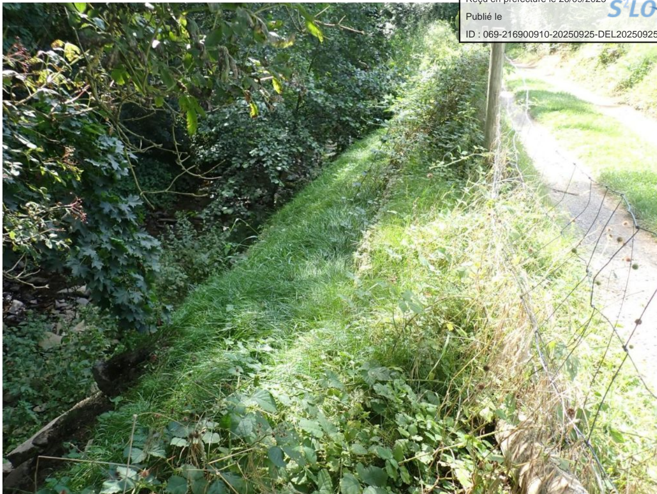
Quelques mois après le débâchage complet on observe aucune repousse de renouée, la strate herbacée recouvre presque totalement l'enrochement (juillet 2024)
