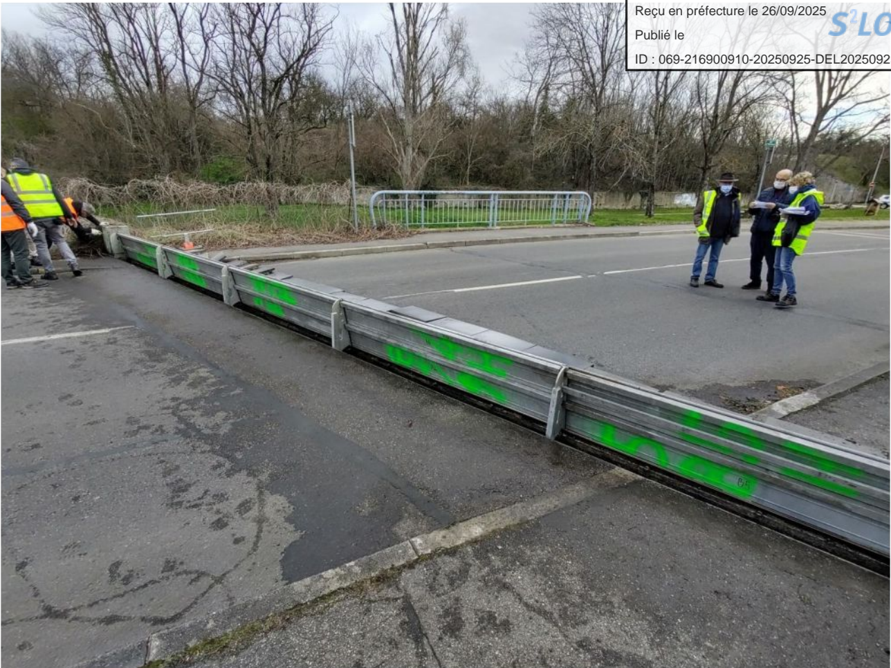
Figure 1 : Batardeau de la commune de GIVORS, faisant partie des ouvrages de protection locales du système d'endiguement n° 4 du SMAGGA
