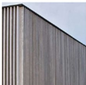
Bardage bois à lames verticales Fond de loggia
