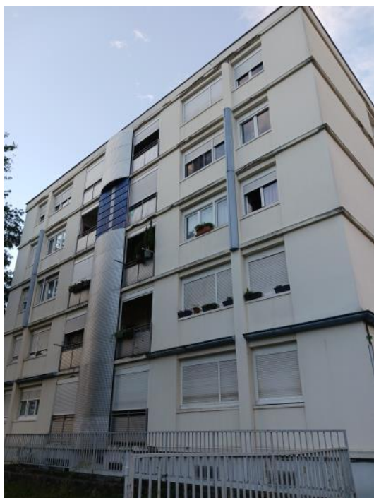
Copro Renée Peillon avant travaux
