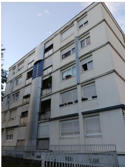
Copro Renée Peillon avant travaux
