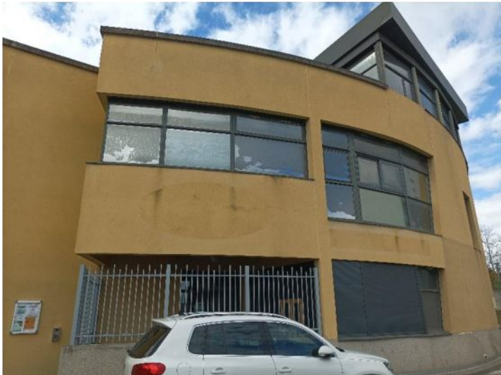
Figure 2 vue extérieur pleine Est du local, situé au 1er et 2eme étage du bâtiment
