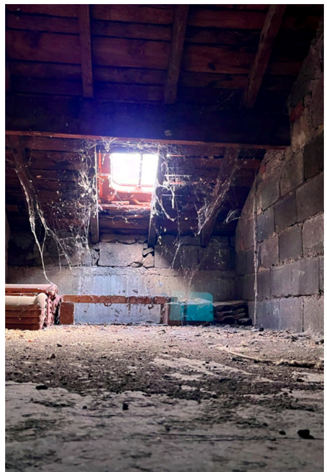
combles du 2 rue Victor Hugo (source CAUE)
