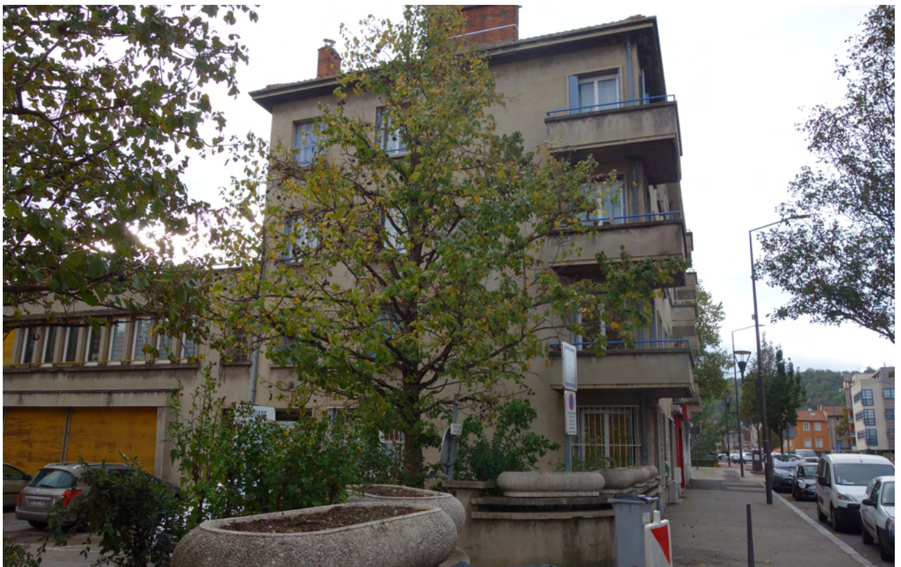
vue sur la façade nord du n°6 rue Victor Hugo (source : photo personnelle)
