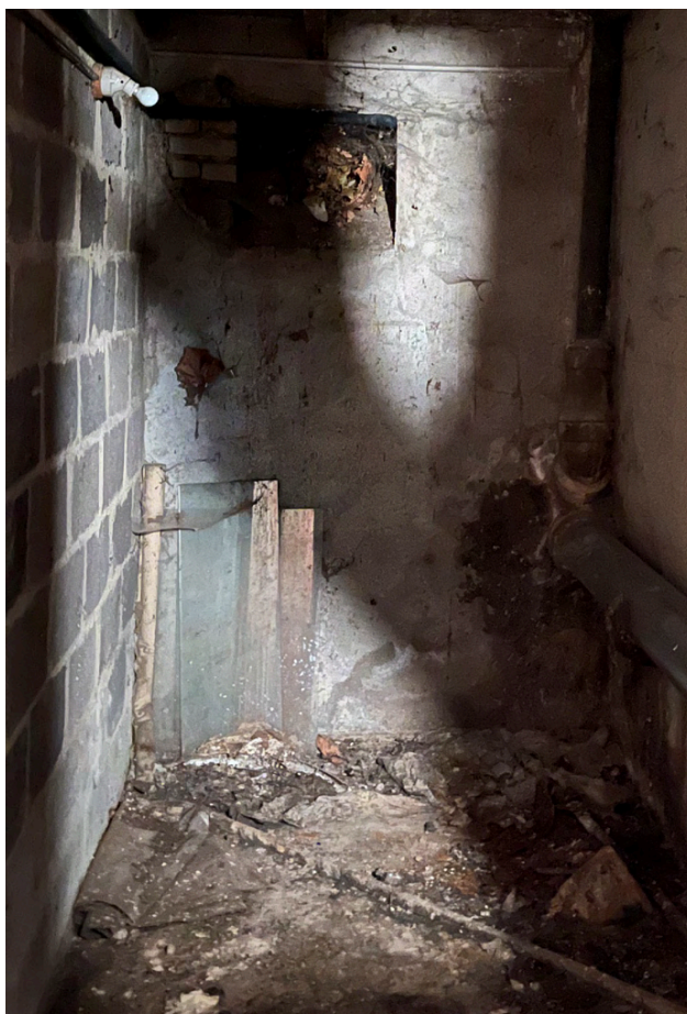
sous-sol du 2 rue Victor Hugo (source CAUE)
