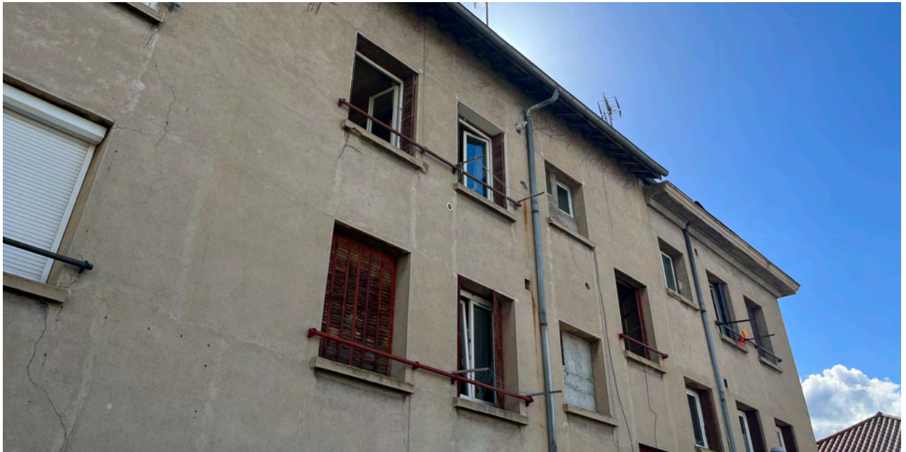
façade arrière du 5 rue Victor Hugo (source CAUE)
