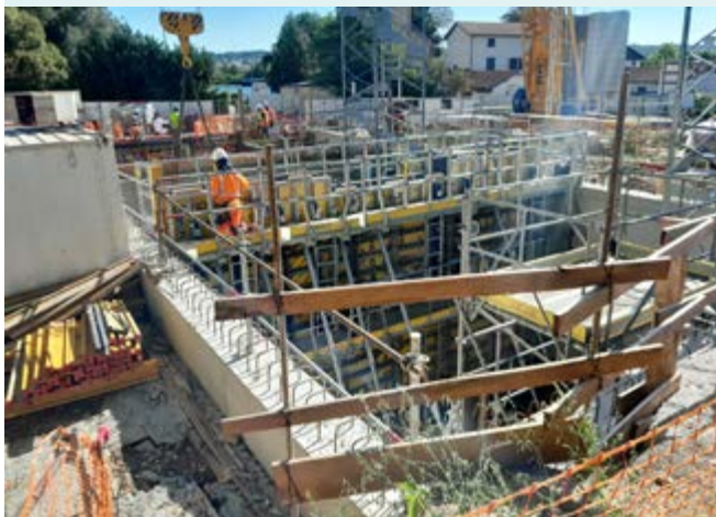
Vue de la future station d'épuration.
