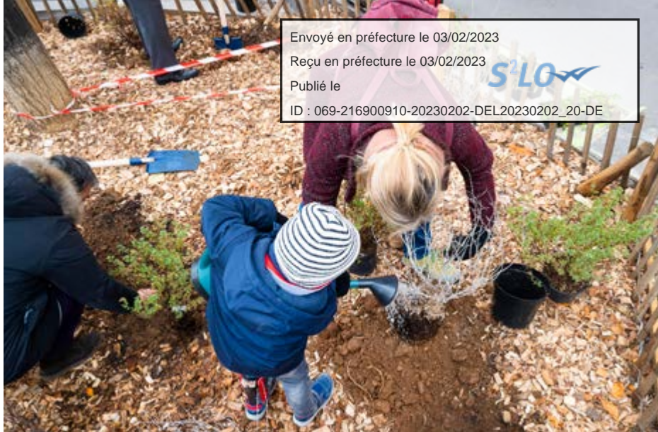
Fosse d'arbre de pluie en cours de plantation, rue Vauban.
