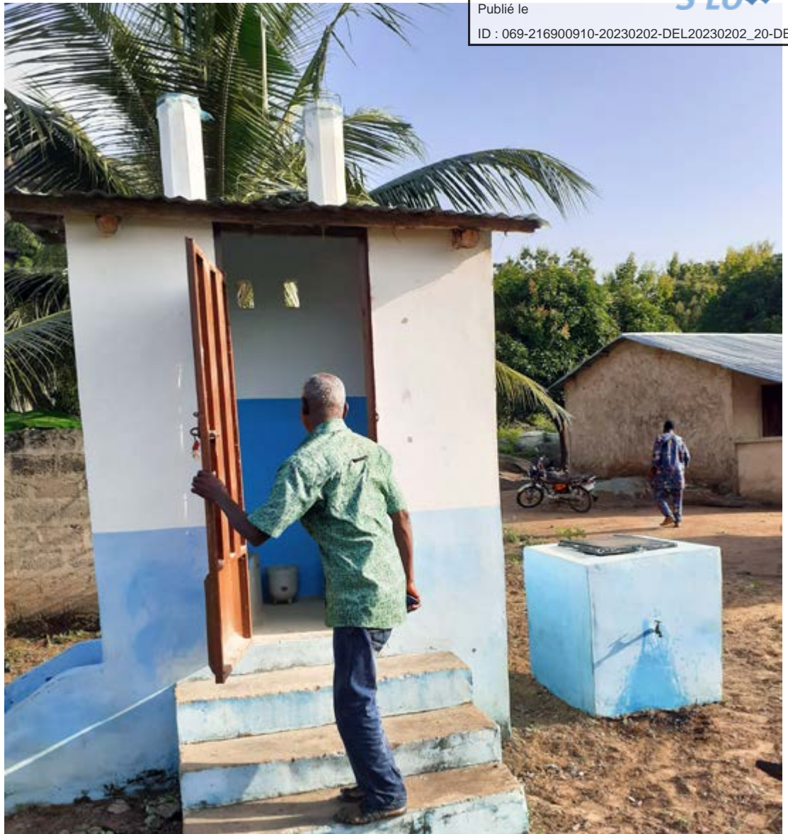
Latrine familiale au Togo.
