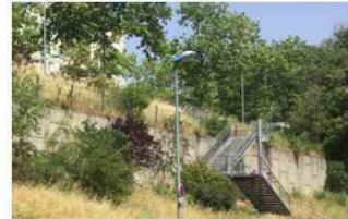
escaliers, allée Jean Moulin
