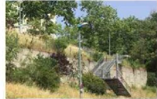
escaliers, allée Jean Moulin
