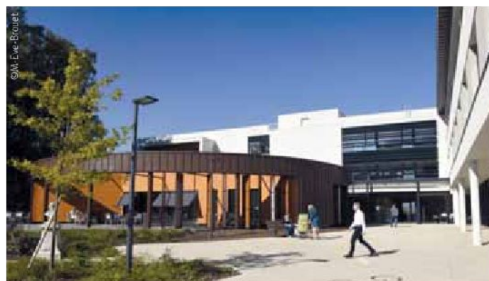
Hôpital Andrevetan à La Roche-sur-Foron (74) [ construction ]
