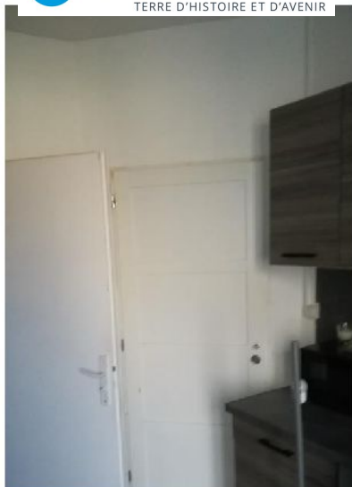
Cuisine : Absence de bouche de ventilation permanente
